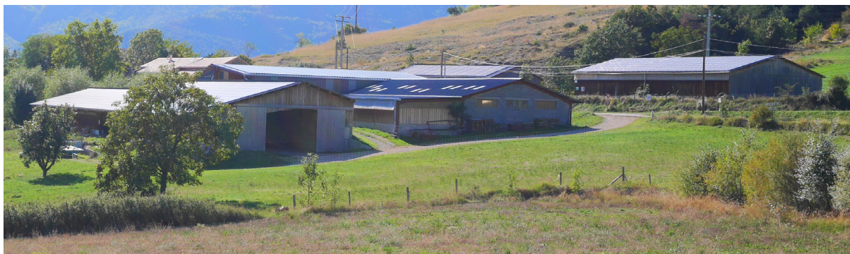
Photo 21. Panneaux photovoltaïques sur bâtiments agricoles (culture et élevage), Vitrolles (© GeographR).
