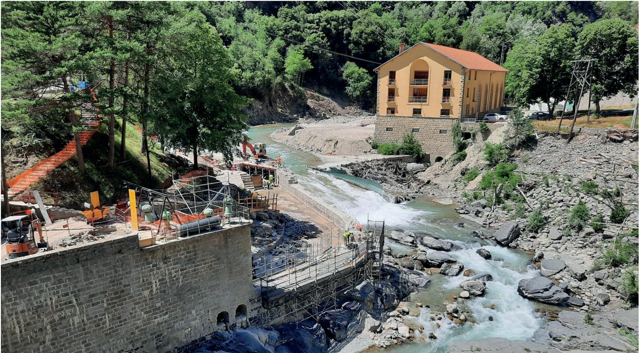
Photo 17. Travaux de remise en état de la prise d'eau à Saint-Jean-la-Rivière, ouvrage de tête du canal de la Vésubie (© ARS PACA).
